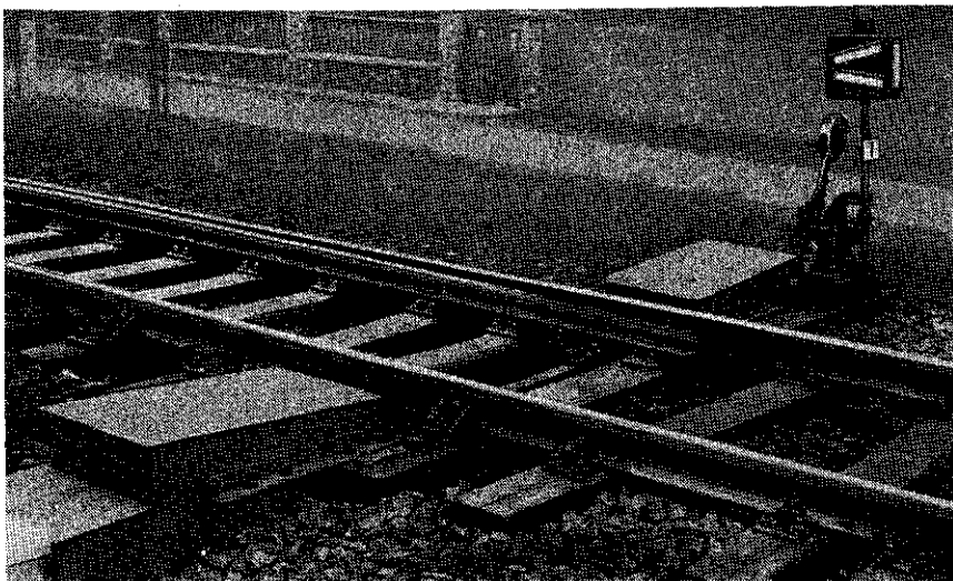
Foto 17 Mechanický prestavník a zâvorník na výhybke
