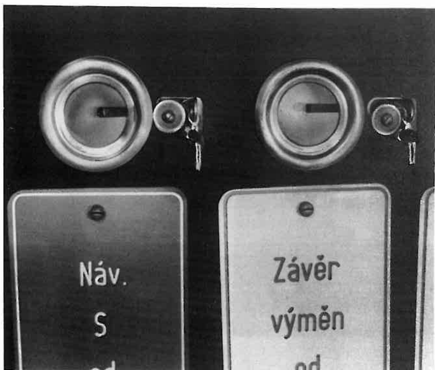
Foto 79 Núdzové vybavovacie zariadenie hradlových záverov na striedavý prúd
