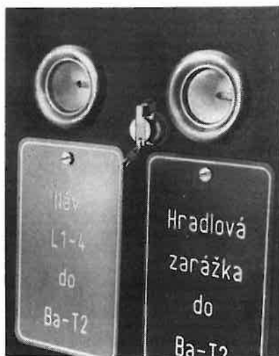
Foto 79 Núdzové vybavovacie zariadenie hradlových záverov na striedavý prúd
